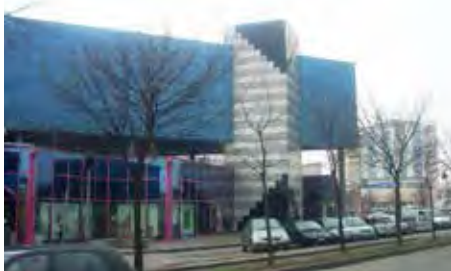
La sede del Centro servizi volontariato di Brescia, in via Salgari 43/b
